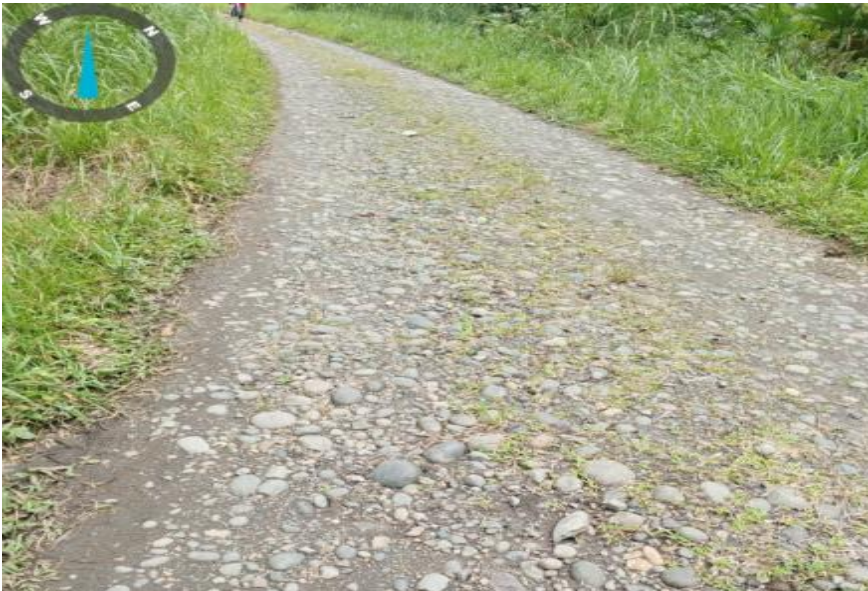
Fotografía 60. Estado de las vías en la zona sur: caminos lastrados
