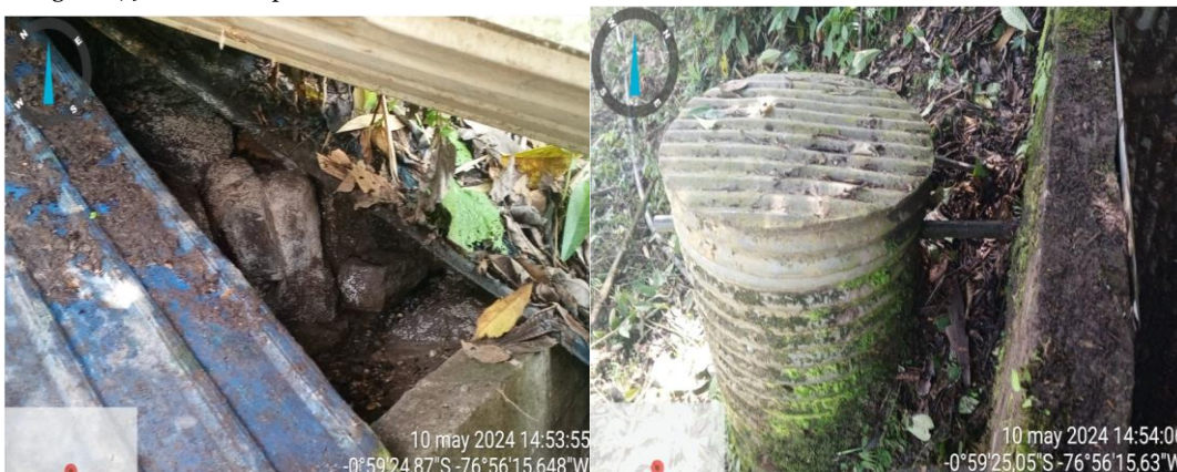
Fotografía 79. Punto de captación de la comunidad San Francisco de Cononaco
