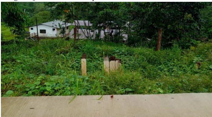
Fotografía 51. Casa derrumbada por acción natural
