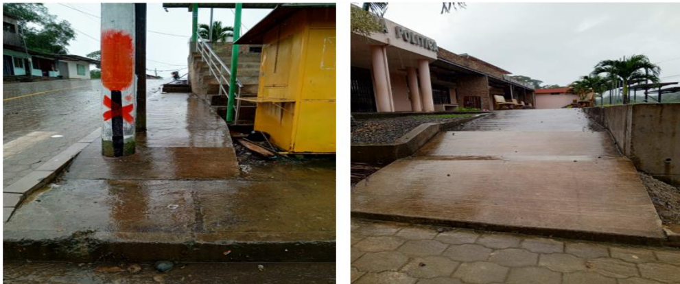
Fotografía 62. Acceso al edificio del GAD parroquial
