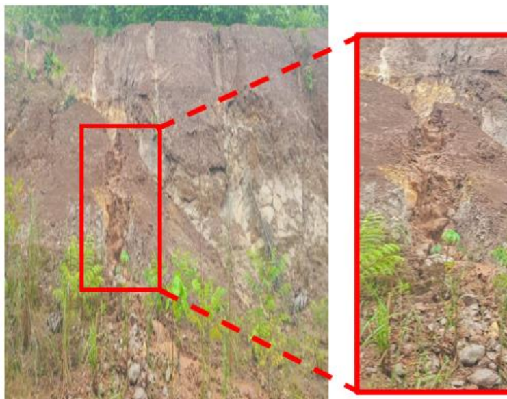
Fotografía 3. Erosión por escorrentía
