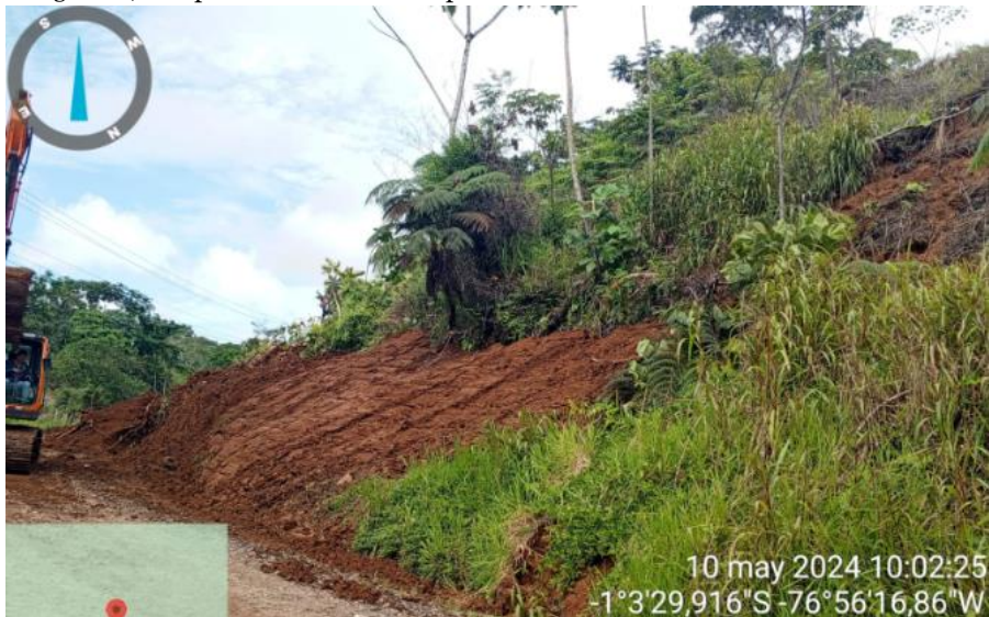
Fotografía 17. Limpieza del material desprendido
