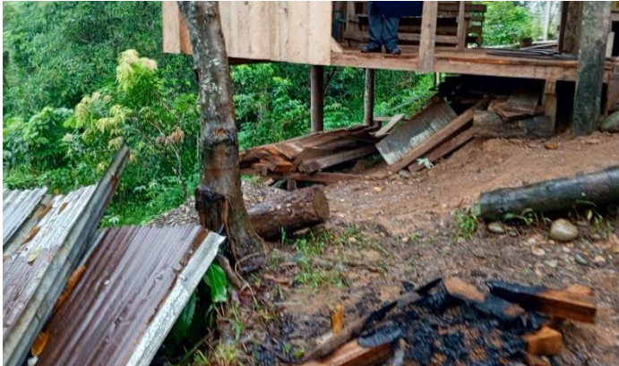
Fotografía 52. Zona trasera de la casa ubicada en la zona de riesgo
